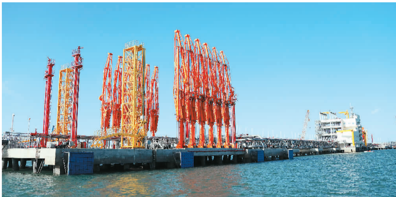
由中国交通建设股份有限公司承建的肯尼亚蒙巴萨油码头项目于2019年2月正式动工，预计2022年4月交付使用。届时，肯尼亚将拥有一座具有国际领先水平的现代化油气装卸码头，能够同时实现原油、重油、汽油、柴油、煤油和液化石油气的进出口转运功能。这将大幅提升蒙巴萨港油气中转能力，为肯尼亚乃至整个东非地区经济发展注入动力。 新华社记者 董江辉摄
