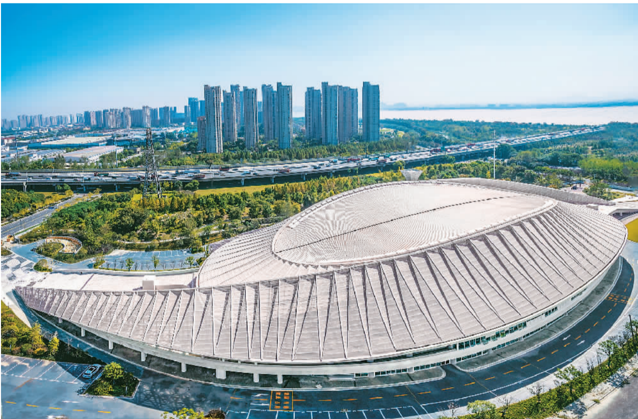
3月31日，绍兴棒(垒)球体育文化中心、绍兴柯桥羊山攀岩基地通过赛事功能验收。至此，历时近5年建设后，杭州2022年亚运会、亚残运会56个竞赛场馆全面竣工并通过赛事功能综合验收。图为杭州亚运会、亚残运会竞赛场馆之钱塘轮滑中心。
