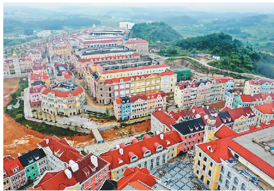
贵州省贵安新区“华为云”数据中心现场。
