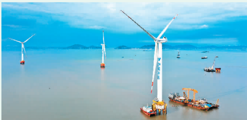
▼ 华电福清海坛海峡海上风电项目首台海上风电主控系统国产化机组（右）（2021年5月28日摄，无人机照片）。新华社记者 姜克红摄
