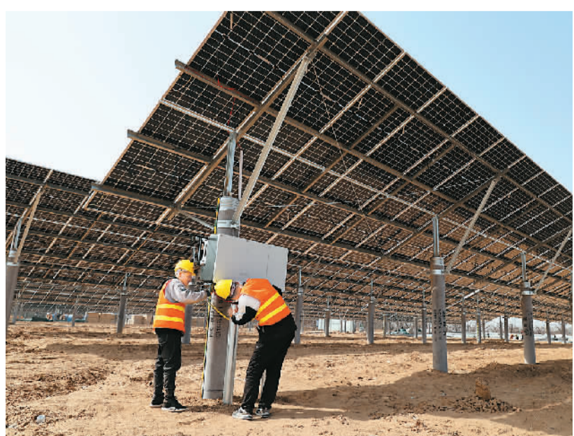
3月11日，河北省邢台市新河县白神首乡光伏电站项目施工现场，工人们正在安装光伏发电设备。李志强摄（人民视觉）
