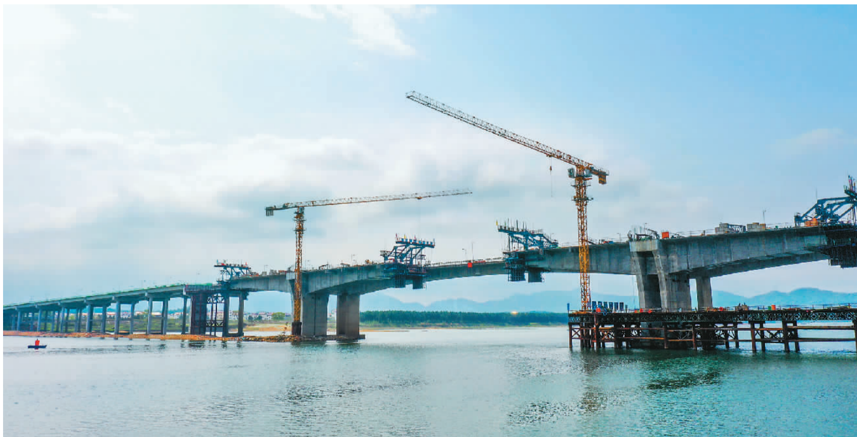
当前,江西省峡江县赣江大桥扩建工程项目正在加紧施工。江西峡江赣江大桥扩建工程全长1495米,作为G322国道的重要组成部分,大桥通车后将有力提升周边地区人流、物流方面的互联互通,对当地经济高质量发展起到有力推动作用。图为赣江大桥扩建工程施工现场。陈福平摄(人民图片)
