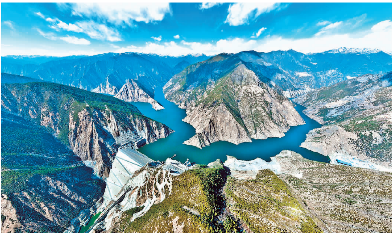
3月18日，中国海拔最高的百万千瓦级水电站——雅砻江两河口水电站最后一台机组完成72小时试运行，正式投入商业运行。至此，两河口水电站6台50万千瓦机组全部投产发电。两河口水电站位于四川甘孜藏族自治州雅江县，是国家和四川省重点工程、西部大开发优化能源供给侧结构性调整的战略工程。
