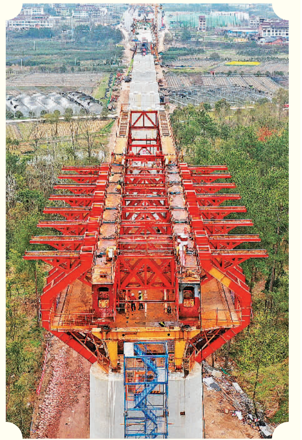
▼ 3月13日，浙江省杭温高铁台州市仙居特大桥施工现场，工人们正在加紧施工作业。王华斌摄（人民图片）
