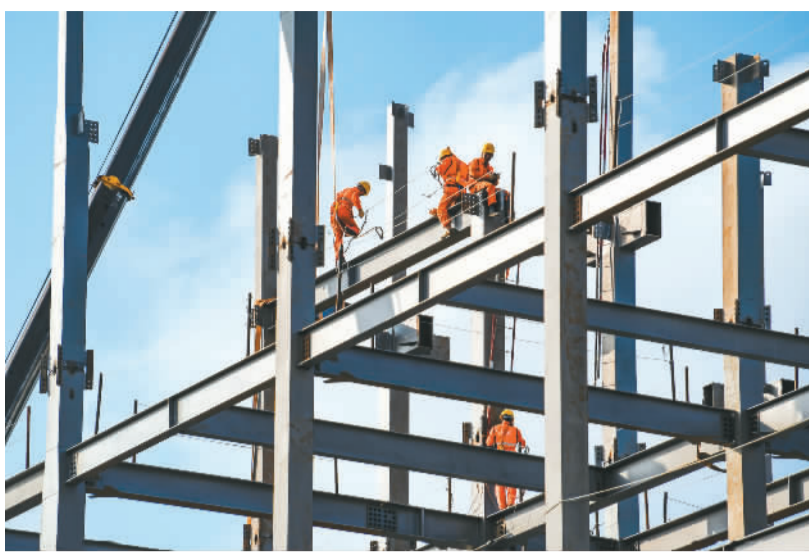
▲ 3月11日，位于海口市江东新区的海南省公共卫生临床中心项目和海南省疾病预防控制中心异地新建项目施工现场，工人们在组装钢结构。
