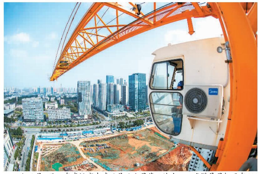
▲ 3月7日，在武汉市中建三局三公司某工地上，一名塔吊司机正在100多米的高空中操控塔吊。
