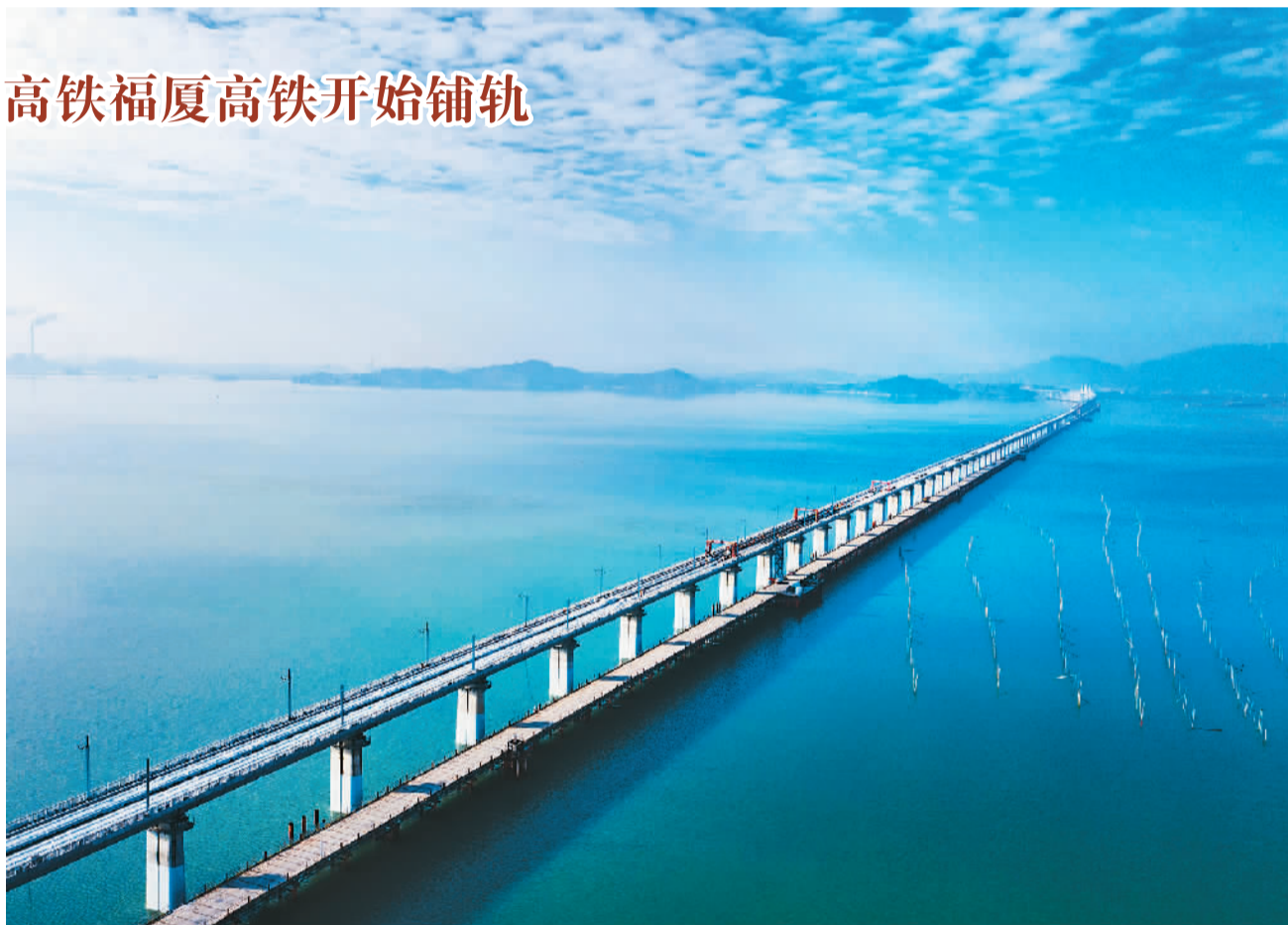
图为施工现场。何卫东摄
