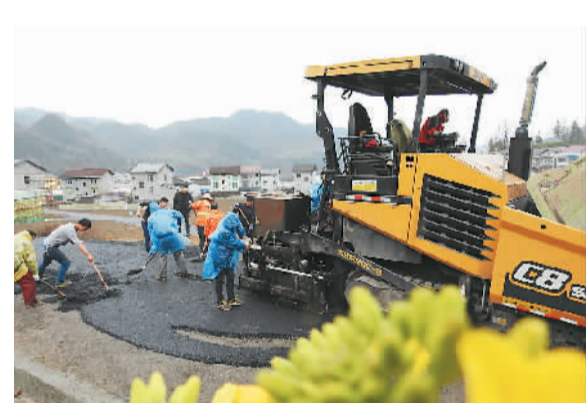
四川省达州万源市坚持把“四好农村路”建设作为老区乡村振兴的突破口来抓。图为3月6日，在石塘镇杉林湾村，工人加紧进行茶叶大豆种植农旅园区的村级公路建设油化作业。 邓良奎摄（人民视觉）
