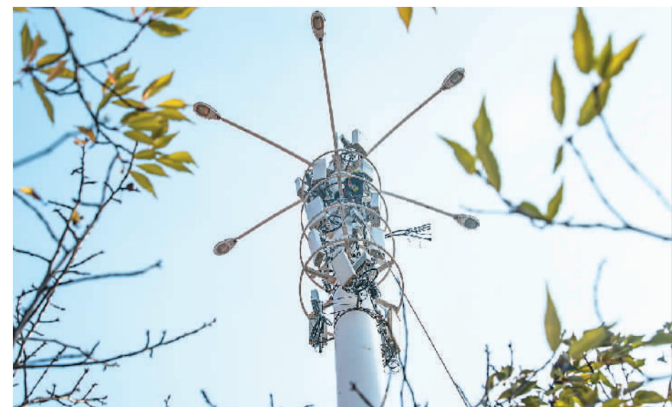
江西省吉安市新干县移动公司技术人员正在安装5G基站设备。
