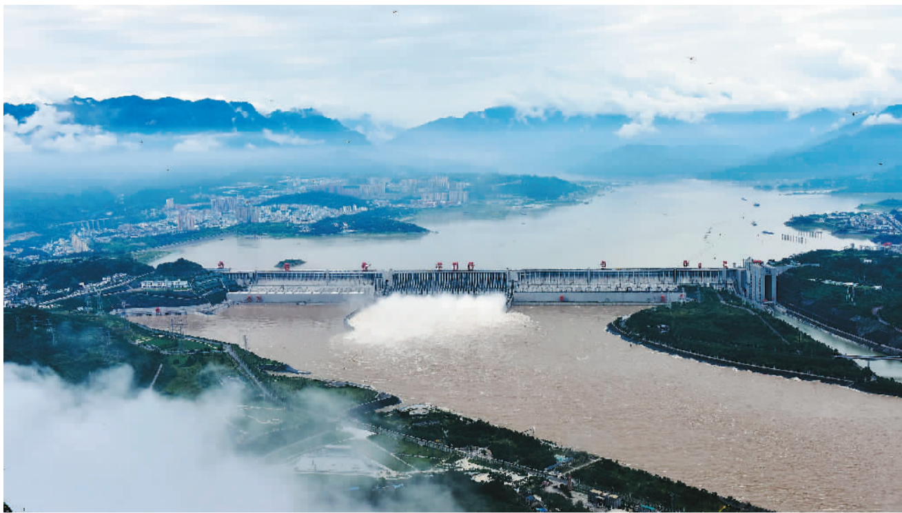
长江三峡水库泄洪腾库。
