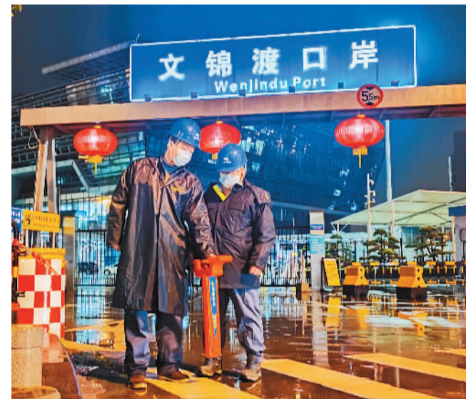
为协助香港应对新冠肺炎疫情、保障对港生鲜食品供应，南方电网近日组织工作人员做好口岸、深港跨境货运枢纽等重点用户和关键场所的保供电工作。图为南方电网深圳罗湖供电局工作人员在文锦渡口岸探测电缆线路。 叶杰摄
