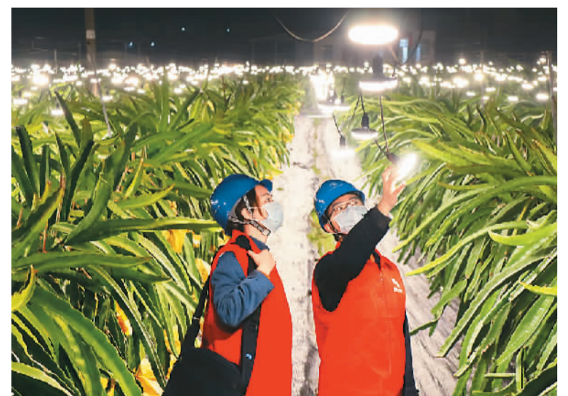
入春以来，广东惠州市供电部门根据春耕生产用电特点，主动当好农民的“电管家”，开展春耕春耕特巡特维和专项用电检查行动，确保春耕生产“电力十足”。图为2月21日，在惠州惠东火龙果种植基地，南方电网广东惠州供电局工作人员在进行用电检查和夜巡测温。 陈奕莹摄（人民视觉）
