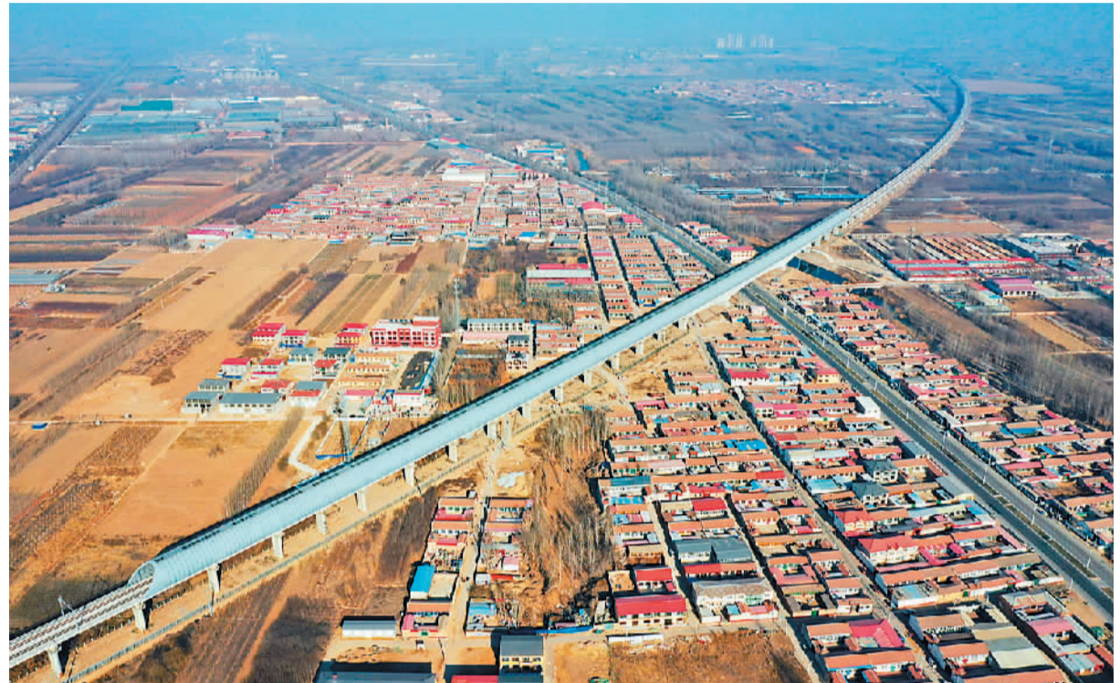
京雄城际铁路河北霸州段的全封闭声屏障。
