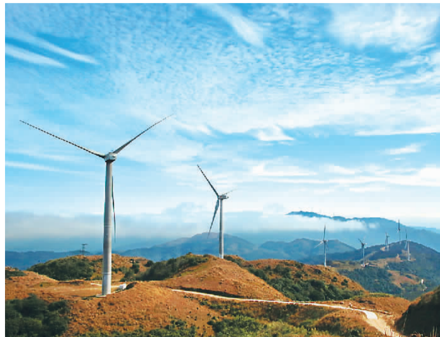
近年来，广西玉林市因地制宜发展清洁能源，以清洁能源助力经济社会绿色低碳转型。近日，南方电网广西玉林供电局顺利完成玉林市第十四座风电场一百一十千伏昌鸿风电场并网送电。项目并网后，每年可输送二百七十万千瓦时绿色清洁能源。图为矗立在高山上的昌鸿风电场发电机组。
