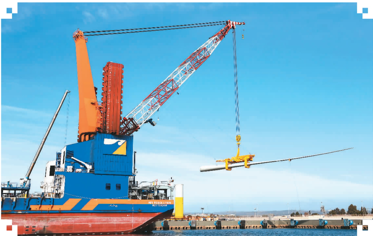
意大利南部的塔兰托港正在建设风电项目，中国明阳智慧能源集团股份有限公司（明阳智能）为该项目提供了10台风机，总功率为30兆瓦，可以满足近两个家庭的用电需求。除提供设备外，明阳智能还与客户签署了为期20年的运维合同，提供全周期运维服务。图为作业船近日在塔兰托港吊运中企提供的风电叶片。
