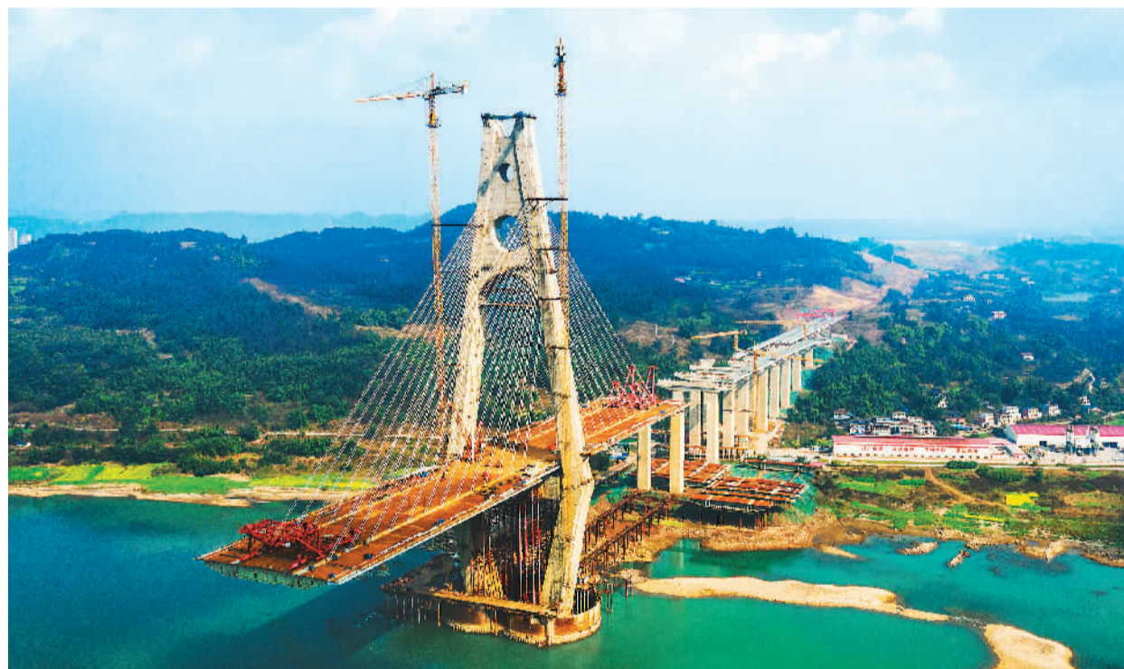
春节过后,四川宜宾临港公铁两用长江大桥加快建设进度。大桥全长1742.1米,主桥长1073米,桥面宽63.9米,主跨522米,是时速350公里自宜高铁的控制性工程。 严程程摄(人民视觉)
