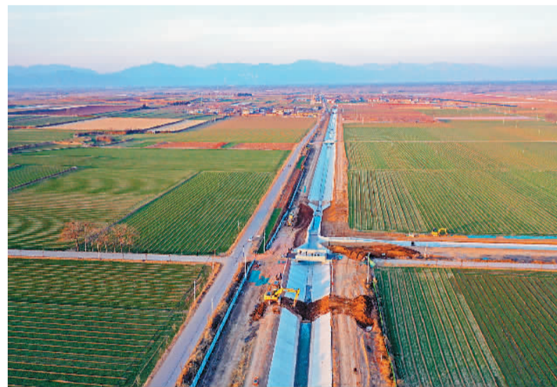
2021年12月30日，黄河小浪底北岸灌区工程河南孟州西冶段施工现场，工人们冒着严寒加紧施工，进行围堰拆除和衬砌施工作业。小浪底北岸灌区工程是国务院确定的172项节水供水重大水利工程之一，对构建黄河北岸清水走廊，改善区域生态环境，增加粮食生产能力具有重要意义。 白水平摄（人民视觉）
