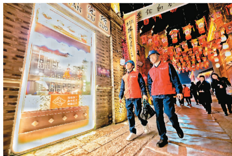
▲ 春节假日期间，安徽省芜湖供电公司为保障芜湖市西河古镇老街用电安全，员工值守岗位，巡查用电设施。 赵晶晶 何煜 摄影报道
