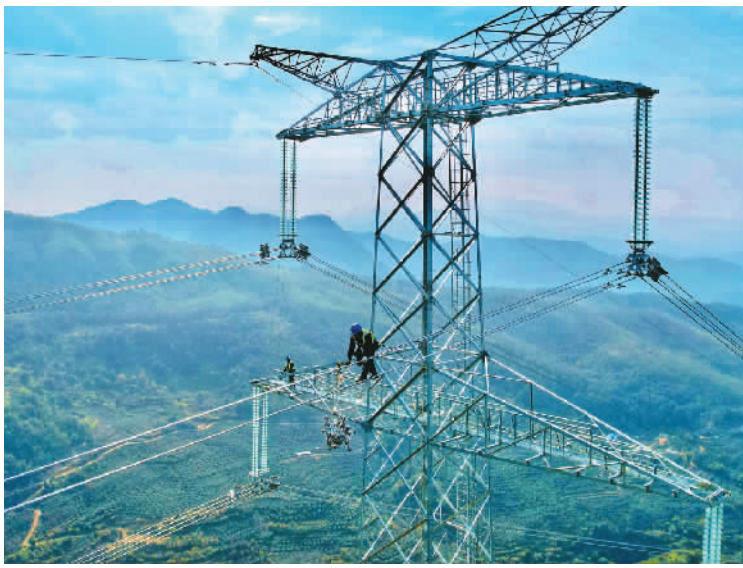
日前，为加快南粤联网工程建设，南方电网工作人员在粤联网工程（广东段）进行高空走线，开展线路消缺工作。据悉，该工程建成后，将促进粤港两省电力互补余缺，进一步优化粤港澳大湾区与海峡西岸经济区能源结构，提高粤港澳大湾区能源保障能力。
