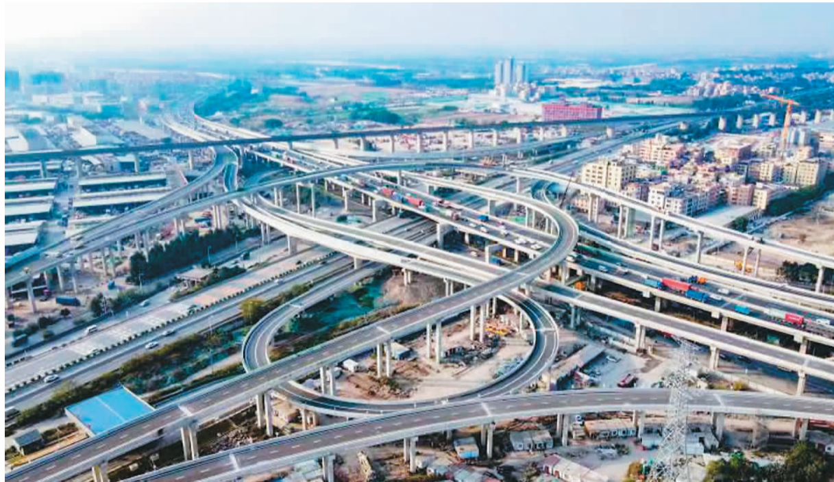
1月16日，广佛肇高速公路广州石井至肇庆大旺段（广州段）咽喉工程朝阳互通立交枢纽正式开通运营，标志着广佛肇高速公路全面建成通车。图为朝阳互通立交。冯学亮摄
