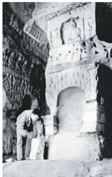
▲1983年，工人在第1窟中心塔柱南侧加砌基石。
