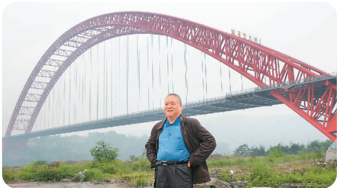
郑皆连主持建设的四川泸州合江长江一桥（二〇一三年建成）是国家高速公路网成渝地区环线控制性工程，跨径五百三十米，是当时最大跨径的钢管混凝土拱桥。图为郑皆连在桥前留影。
