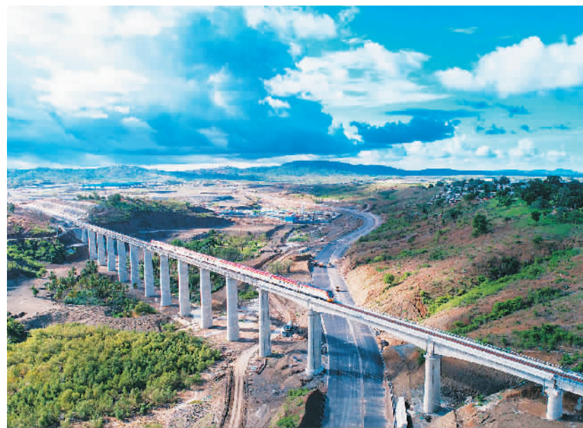
图为二〇一七年五月十二日，列车从肯尼亚蒙巴萨铁路沿线的马泽拉斯铁路大桥上驶过。 新华社记者 陈诚摄 (资料图片)
