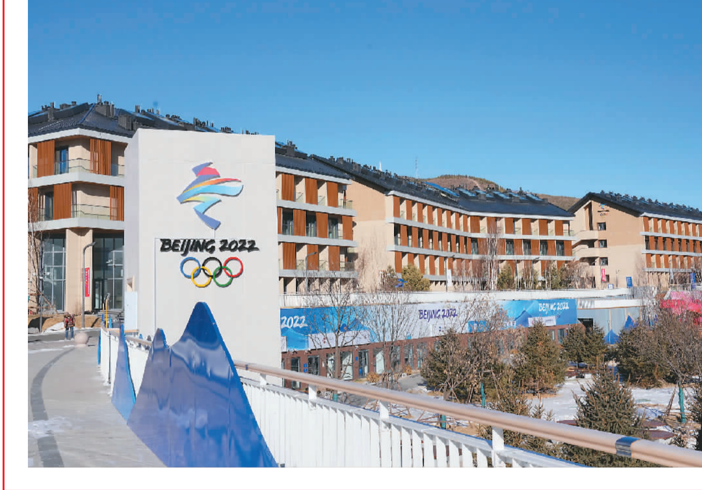
目前张家口冬奥村启动闭环管理，进入赛时状态。图为二〇二二年十二月三十日拍摄的北京冬奥村张家口冬奥村（冬残奥村）。新华社记者 杨世尧摄
