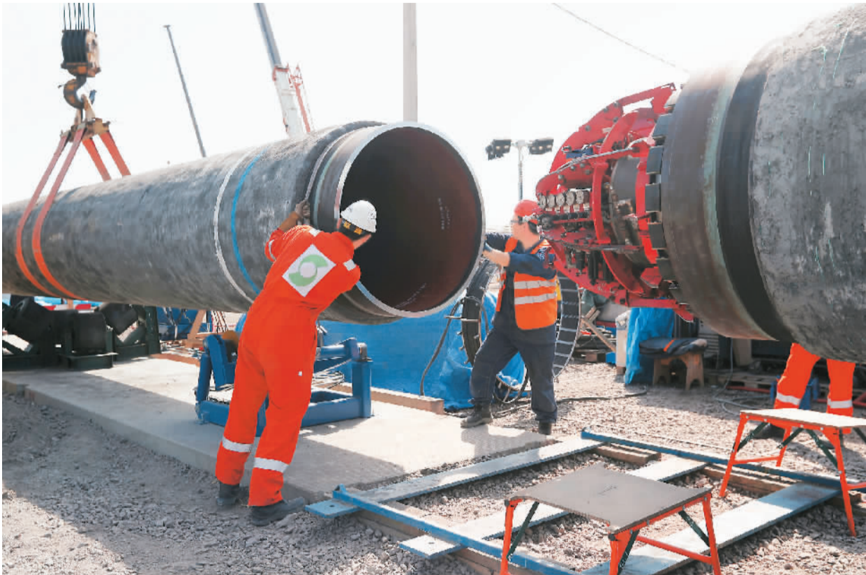
俄罗斯“北溪2号”天然气管道项目第二条支线的最后一节管道完成焊接。这张二〇一九年六月五日的资料照片显示，工人在俄罗斯全吉谢普附近“北溪2号”天然气管道项目现场施工。 新华社路透
