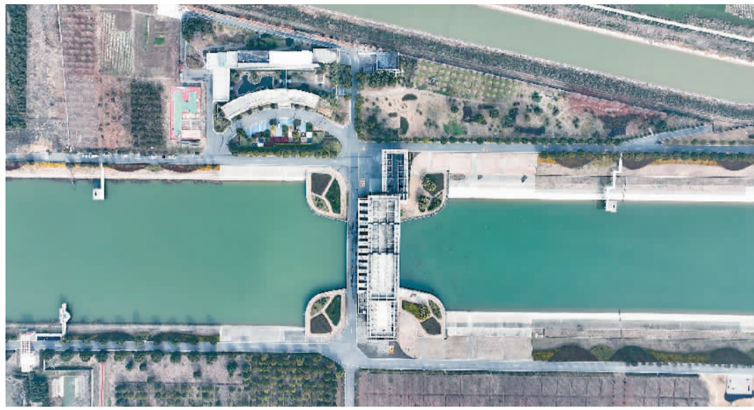
图为1月8日拍摄的南水北调东线江苏省淮安市洪泽站。 万震摄(人民视觉)
