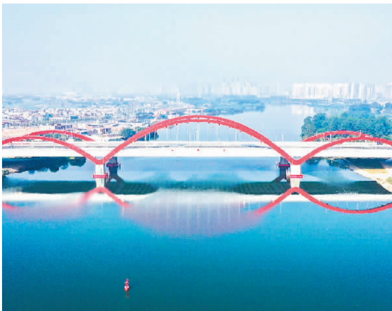
1月3日，跨越九龙江西溪的福建省漳州市东环城路马洲大桥正式通车，成为厦门通往漳州主城区的又一通道，是目前国内已建成最宽的中承式钢拱桥。图为马洲大桥。 刘天宇 林聪华摄影报道
