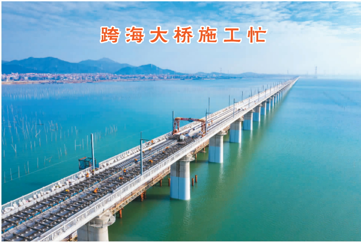
连日来，位于福建省泉州市的福厦高铁湄洲湾跨海大桥施工现场一片忙碌。福厦高铁湄洲湾跨海大桥长14.7公里，海域施工长10.8公里，是国内首座跨海高铁矮塔斜拉桥。图为建设者正在进行无砟轨道施工。
