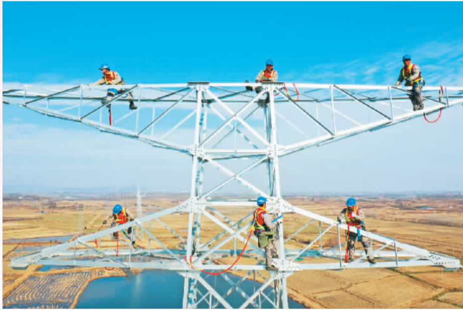
▲ 1月3日，安徽省滁州市全椒县220千伏八波输电工程建设工地，电力工人在70多米高空进行组塔作业。 宋卫军摄（人民视觉）
