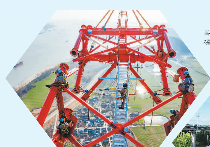
▲2021年12月26日，安徽送变电工程有限公司施工人员在长江大跨越特高压输电钢塔塔顶施工现场作业。 郑贤烈摄（新华社发）
