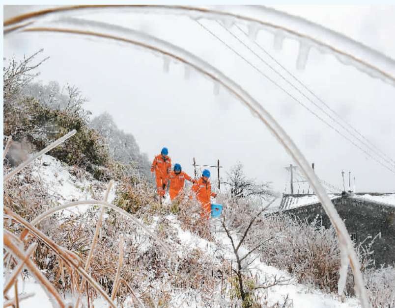
▲ 2021年12月26日，在贵州省黔东南州雷山县，南方电网党员服务队在海拔1700余米的雷公山半山腰上巡视线路。 蔡兴文摄（人民视觉）
