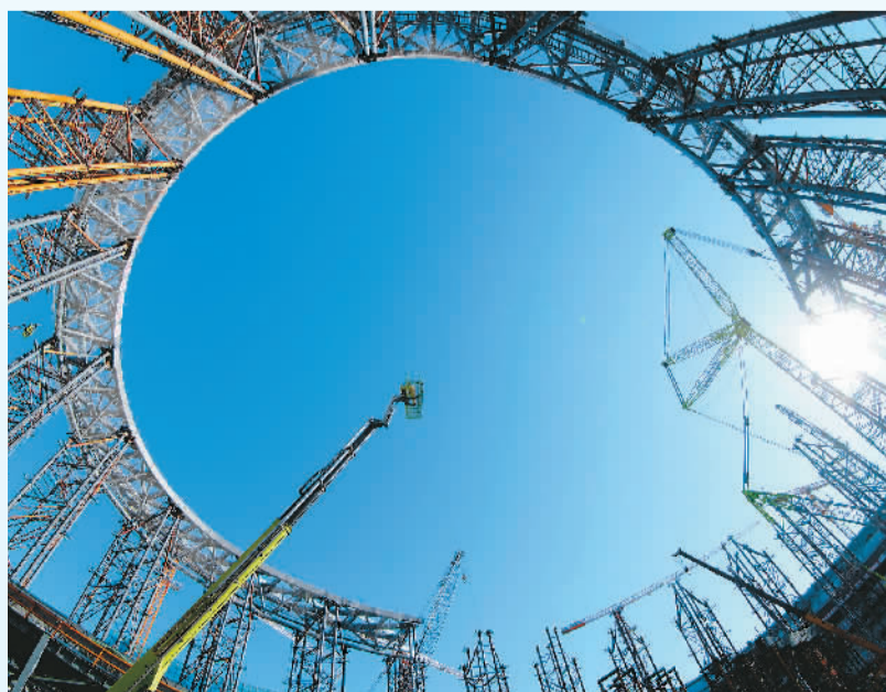
▲ 北京工人体育场改造重建工程日前完成主体结构封顶。节前再加一把劲，施工方北京建工集团抓紧进行钢结构罩棚施工。本报记者 贺勇摄
