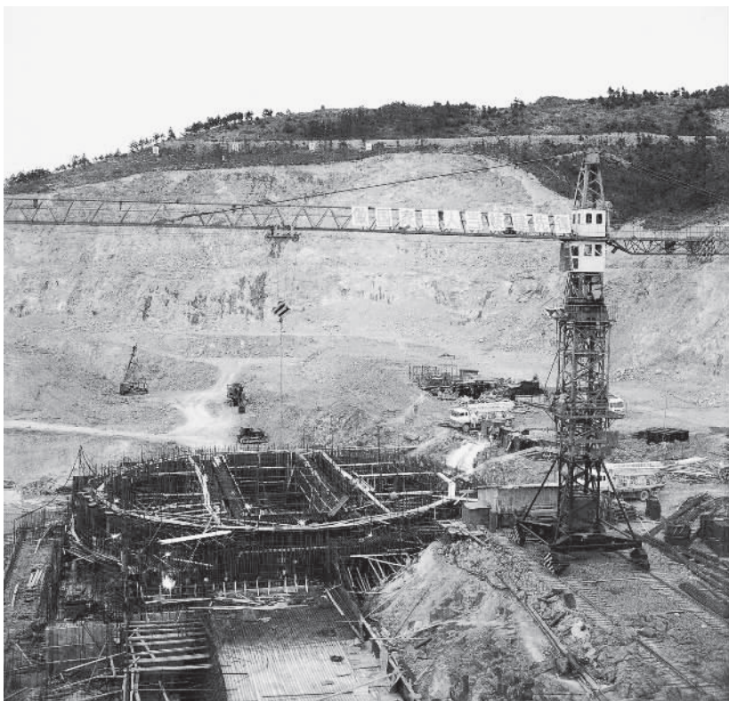
1985年3月20日，秦山核电站浇筑第一罐混凝土。
