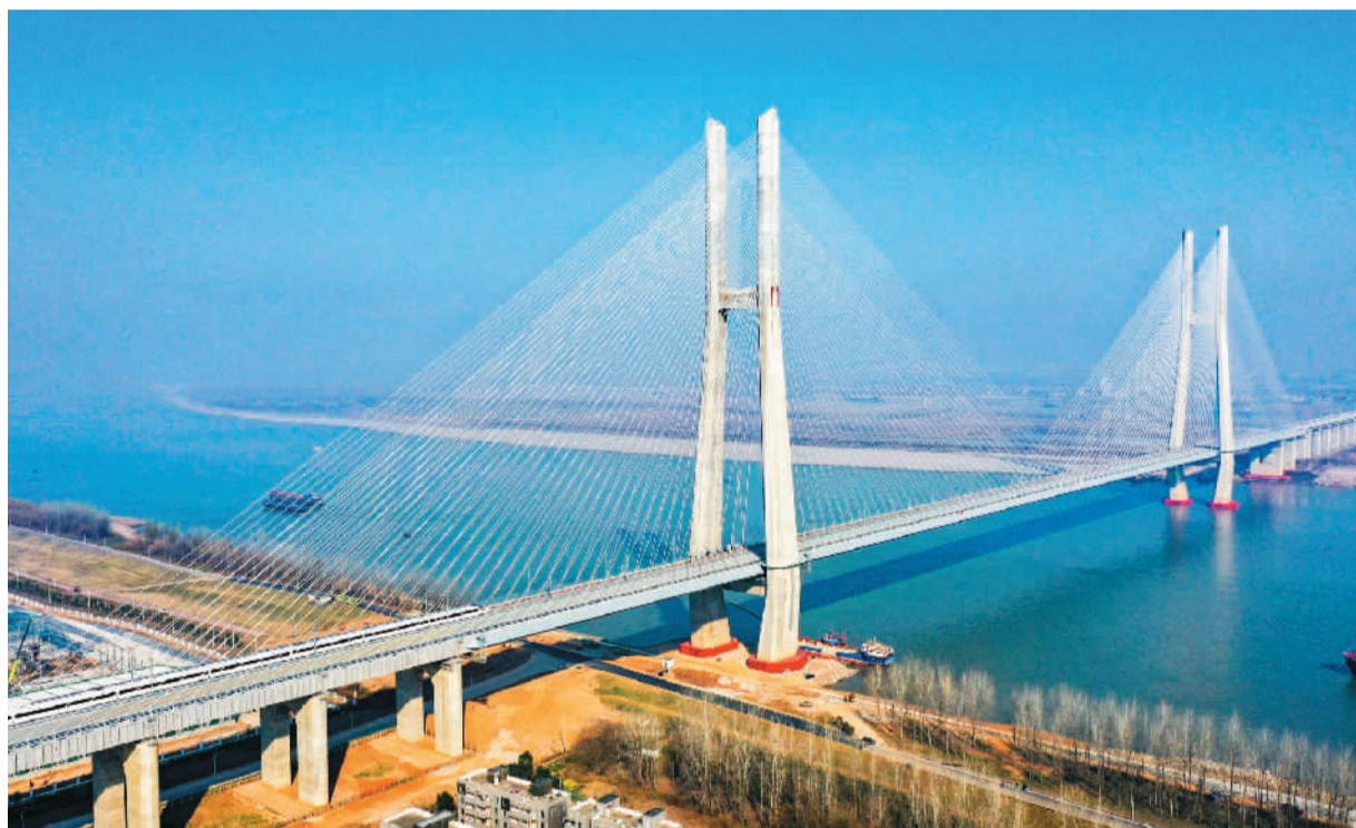
12月30日，京港高铁安庆至九江段正式开通运营。图为合肥南至庐山首发G4791次列车通过鳊鱼洲特大桥。鲍贻生摄 (人民视觉)
