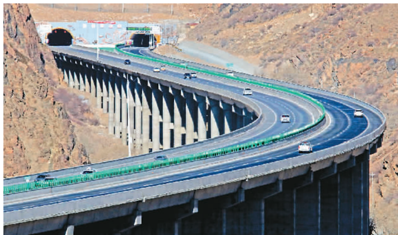
12月26日,新疆哈密东天山隧道建成通车。隧道全长约11.8公里,建设历时5年多,是新疆G575公路项目的控制性工程,担负着畅通哈密天山南北交通的重任。图为隧道外景。蔡增乐摄
