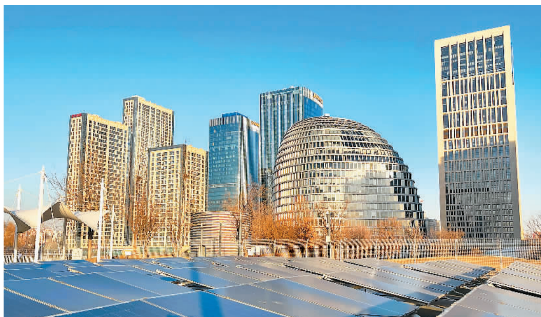
图为北京冬奥村光伏发电电现场。胡庆明摄(人民视觉)
