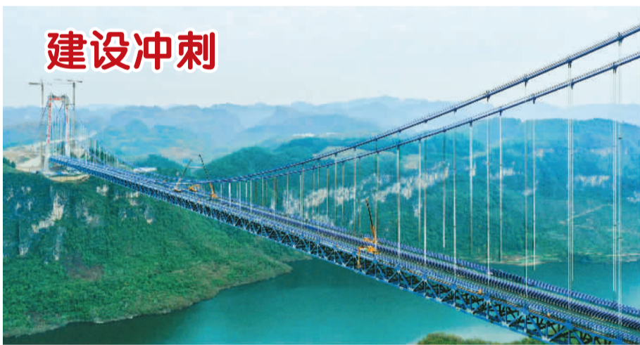
开州湖特大桥是贵州境内瓮开高速公路的控制性工程,全桥长1257米、主跨1100米,桥面距湖面250多米。目前该项目建设已进入冲刺阶段。大桥建成通车后,开阳县至瓮安县的行车距离将由110公里缩短为48公里。袁福洪摄(人民视觉)
