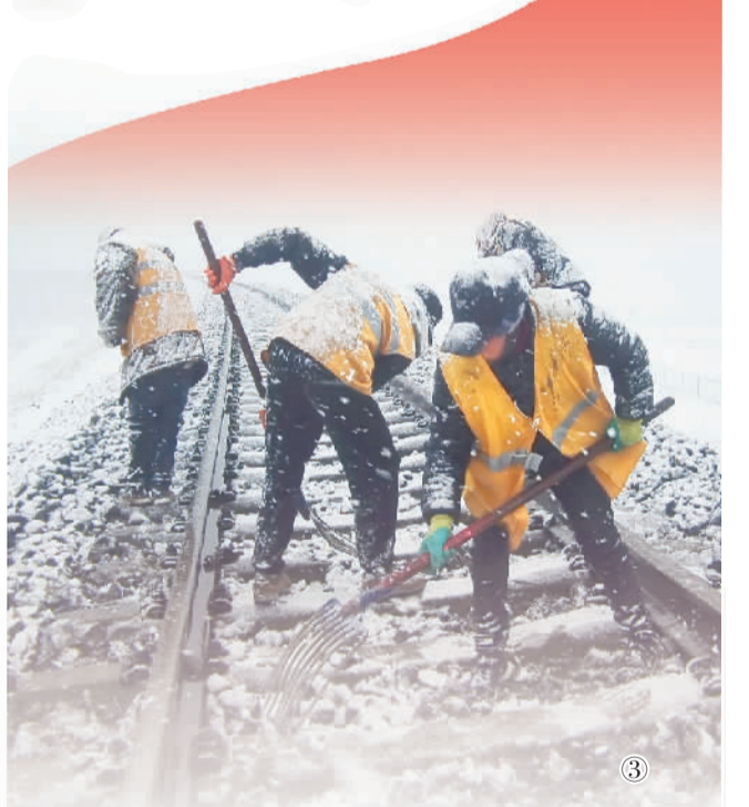
图①：青藏铁路隧道施工时经常发生塌方，建设者奋不顾身开展抢险修复工作。资料照片
