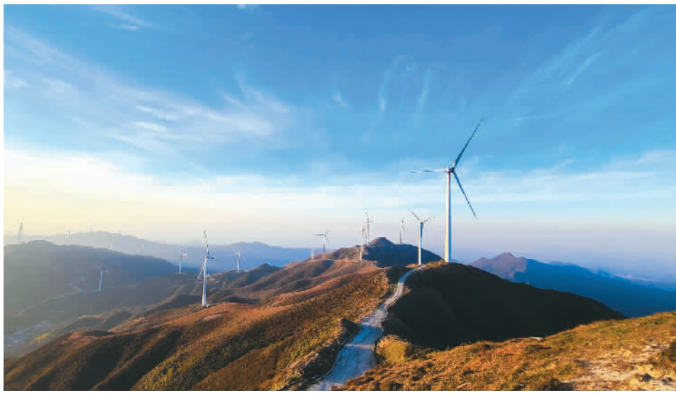
近年来，湖南省郴州市桂阳县积极探索绿色、循环、低碳的可持续发展新路，形成集风力发电、观光旅游、环保示范于一体的风电长廊，助推经济高质量发展。图为桂阳县白水瑶族乡天塘山上，数十台风力发电机擎天矗立。周秀鱼春摄（人民视觉）
