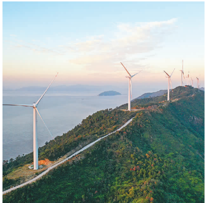
近年来，浙江省玉环市大力推动风电产业发展。玉环市大麦屿响风风电场是当地首座沿海山地风电场，该风电场装机容量49.5兆瓦，自投产以来，年发电量近1.5亿千瓦时。图为玉环市大麦屿响风风电场的风机正在运行。 段俊利摄（人民视觉）
