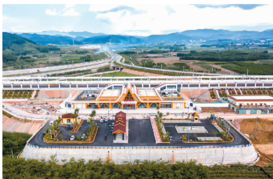
中老铁路国内段的玉(溪)磨(憨)铁路野象谷车站一景。
