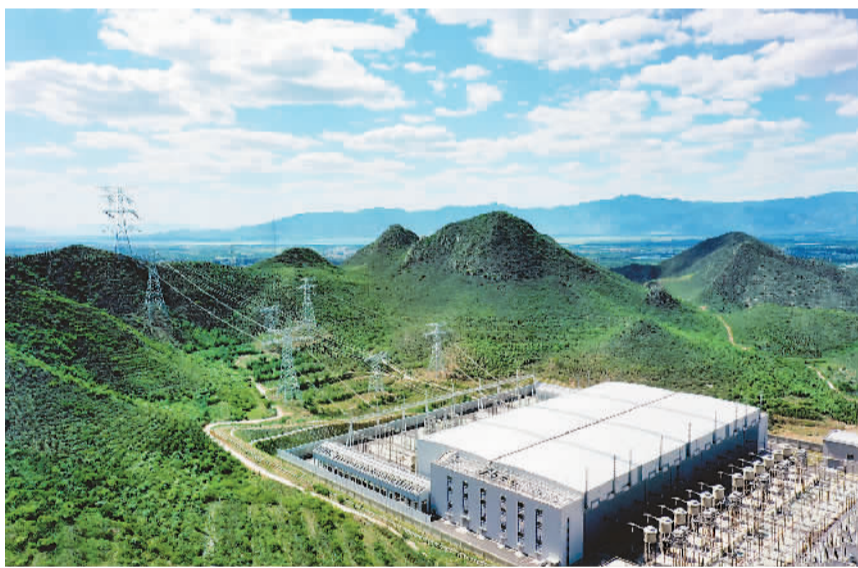
国家电网张北柔直工程延庆换流站将绿电送往北京。
