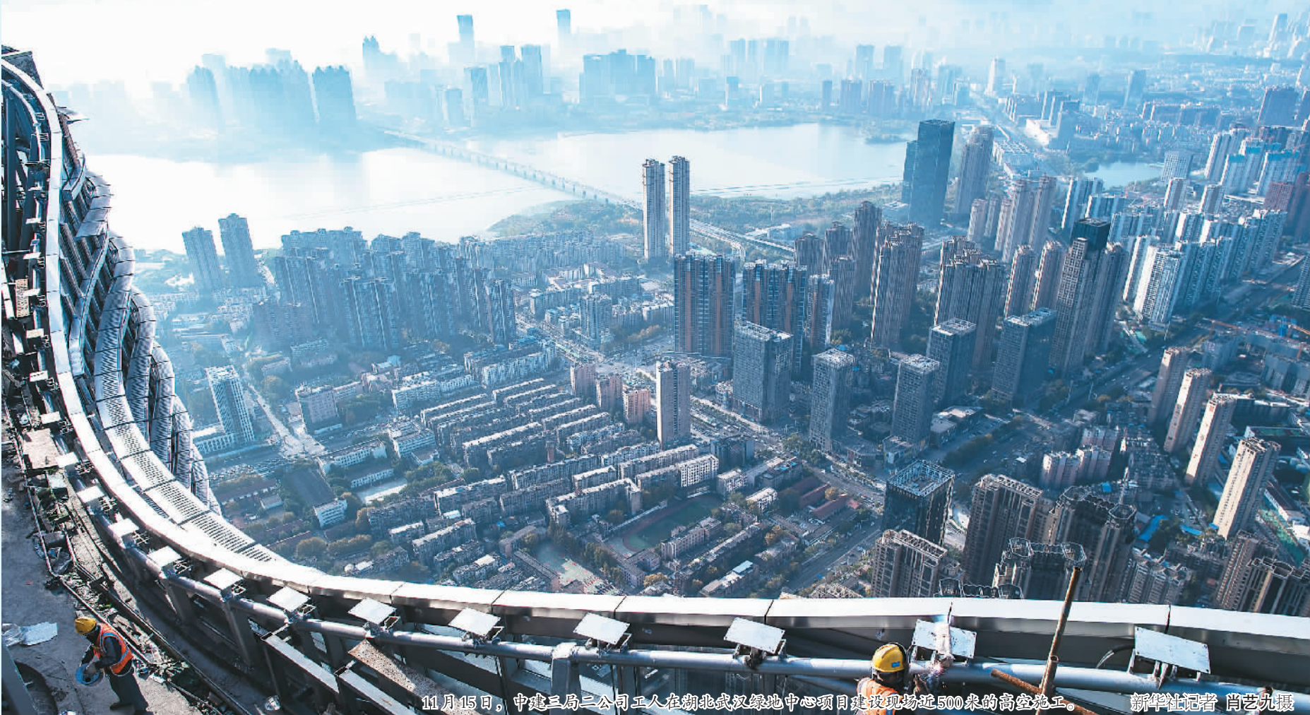
11月15日，中建三局二公司工人在湖北武汉绿地中心项目建设现场近500米的高空施工。新华社记者 肖艺九摄
