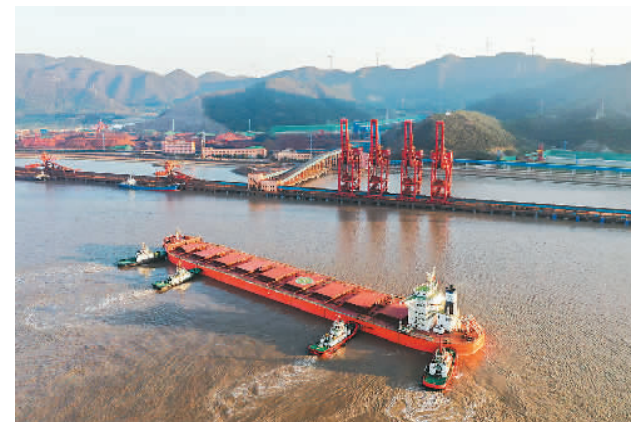
11月15日，浙江省宁波舟山港穿山港区中宅矿石码头，装载着178256吨进口铁矿石的“日照枫叶”轮正在靠泊码头，即将进行接卸作业。蒋晓东摄（人民视觉）
