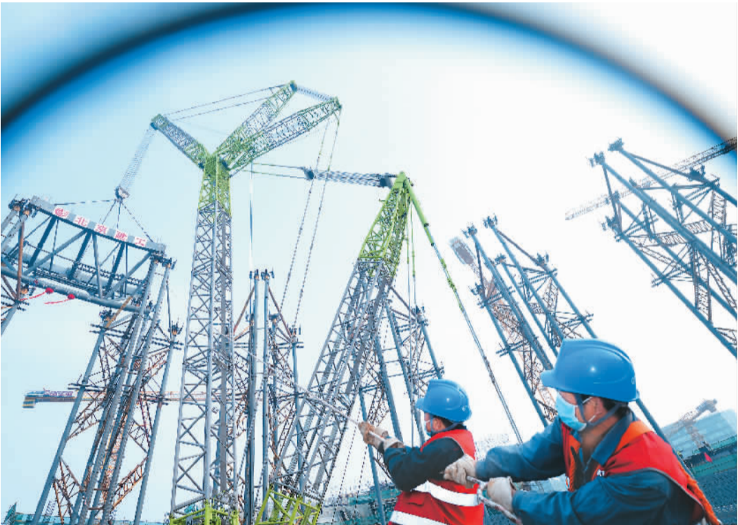
11月18日,北京工人体育场改造重建项目屋顶罩棚第一块重达200吨的钢结构部件吊装就位,标志着该项目钢结构施工全面开始。“传统外观,现代场馆”是本次工体改造重建遵循的原则,在保留工体原有特色元素的同时,为其增加了全新罩棚,可以让新工体提升极端天气下的办赛能力和观赛体验。图为北京建工的工人正在拖拽牵引绳,帮助钢结构部件准确定位。本报记者 贺勇摄
