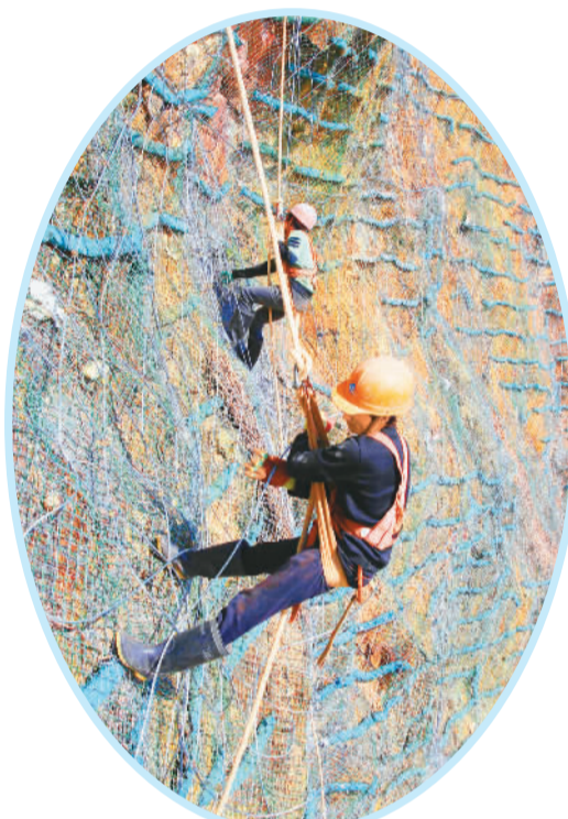
浙江省温岭市坞根镇新方废弃矿山边坡锚固绿化修复工地，工人正攀援在岩壁上，铺设和加固钩花钢丝绳，固化植绿。刘振清摄（人民图片）
