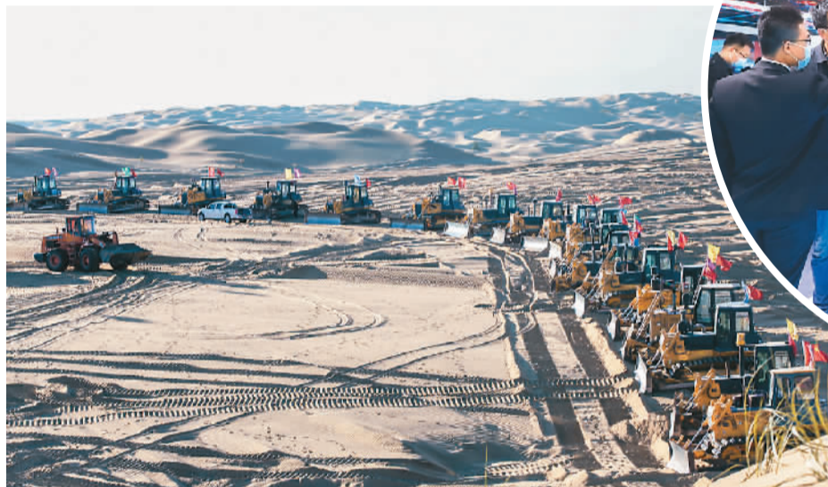
▲10月16日，在内蒙古西基地库布其200万千瓦光伏治沙项目区待命的施工机械。（受访者供图）
