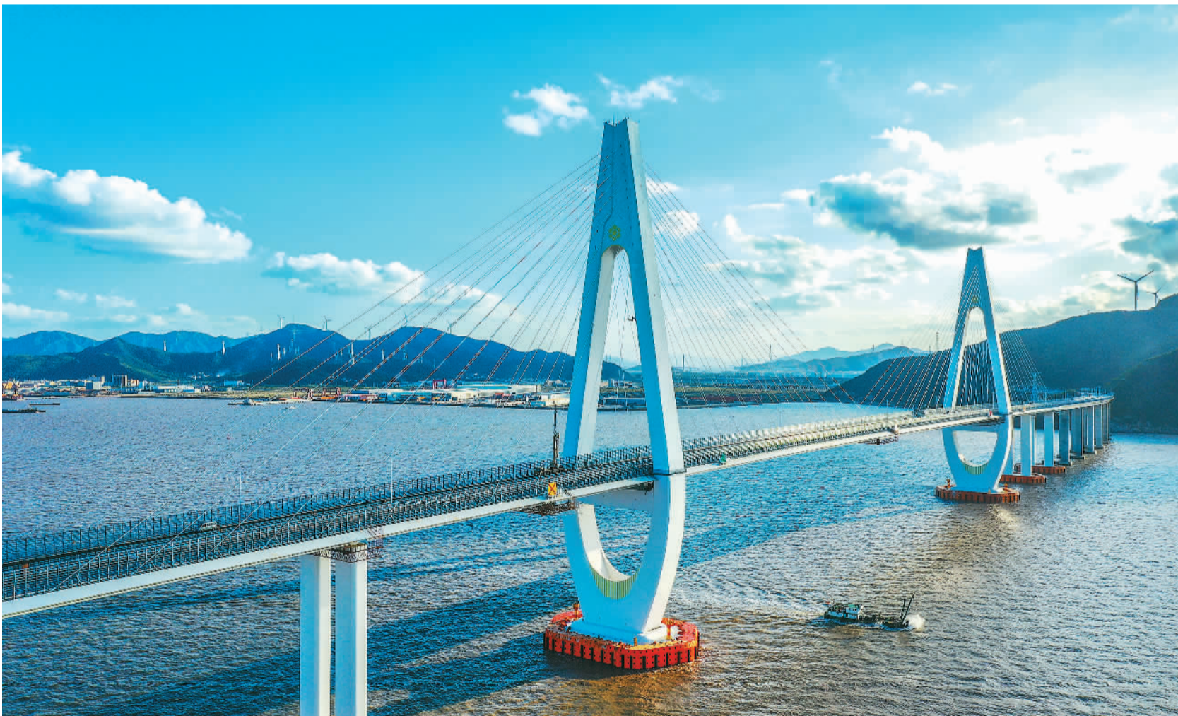
10月28日，随着最后一个施工吊篮的拆除，浙江省交通集团舟岱大桥通航孔桥涂装施工顺利结束，这也标志着舟岱大桥主塔涂装施工全部完成。湛蓝的海面上，形似“玉净瓶”的白色主塔竖立其中，大小船舶穿梭而过，构成一幅灵动的画面，独特的钻石型塔身也成为舟山的代表性建筑。姚峰摄（人民视觉）
