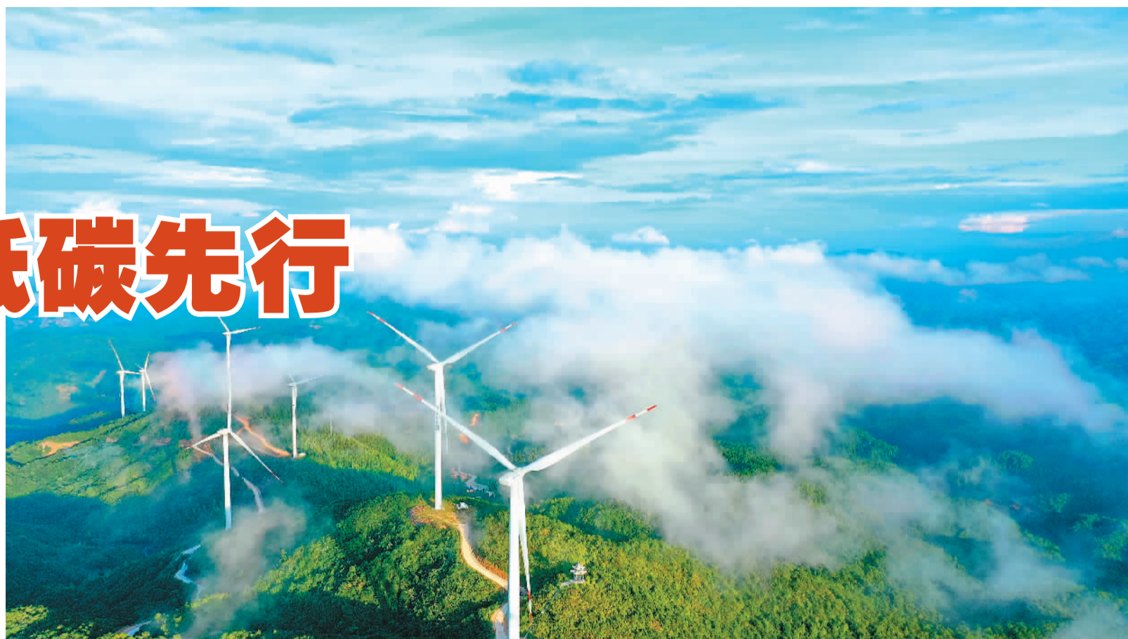
江西省赣州市会昌县清溪乡盘古峰风力发电场，一台台风力发电机矗立在连绵的青山间。盘古峰风力发电场共有26台2000千瓦风力发电机组，每年可节约标准煤38万吨，有效促进节能减排。 朱海鹏摄（人民图片）
